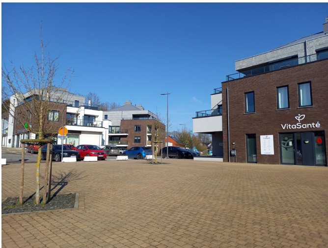
Le nouveau pôle d'accès aux soins – rue Saint-Jean
