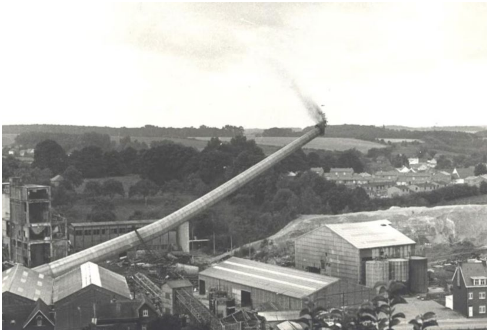
La démolition de la cheminée des papeteries
