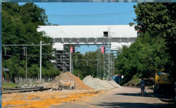
Travaux d'entretien du pont du chemin de fer Page 8
